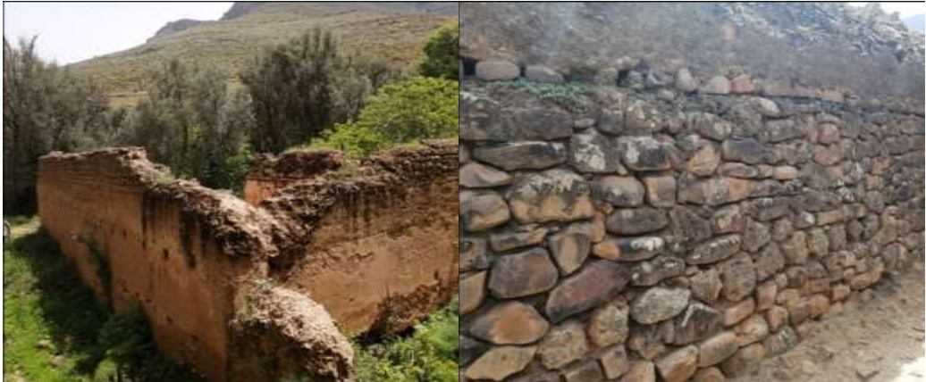
الصورة رقم 09 تغير لون الحجارة نتيجة لعوامل التلف الطبيعية
