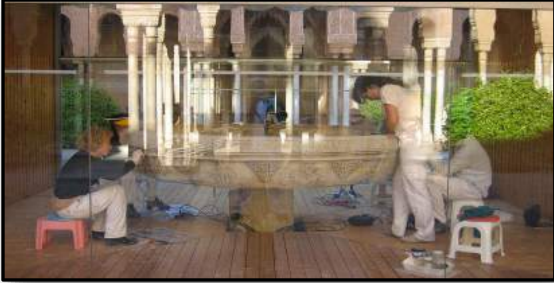
الصورة رقم : 03 عملية ترميم كتابة النافورة عن : Villafranca y otros
