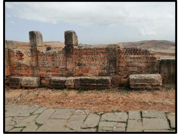
استخدام الحجارة ذات الأخدود في التقنية الإفريقية آثار الملاط على أحد جهات الحجارة (تصوير الباحثة)
