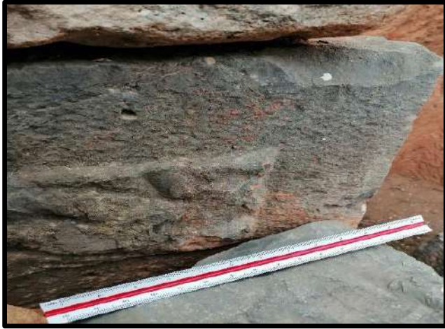
استخدام الحجارة ذات الأخدود في التقنية الإفريقية آثار الملاط على أحد جهات الحجارة (تصوير الباحثة)
