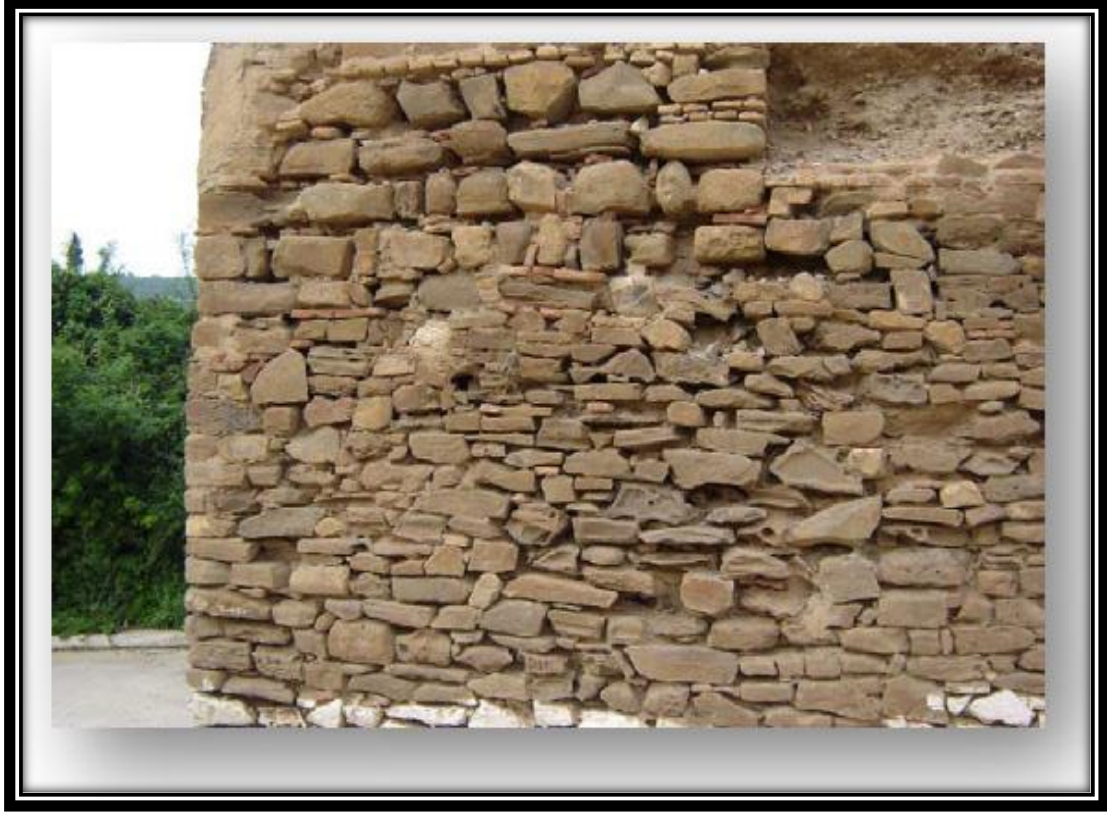
الصورة 4: البناء بالدبش في برج باب البحر.
