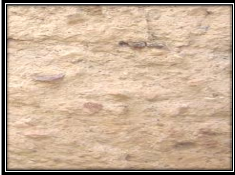
الصورة 5: تقنية البناء بالطابية في باب لبحر
